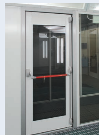
A side personnel door with internal panic bar. Puerta peatonal con cierre antipánico interno.
